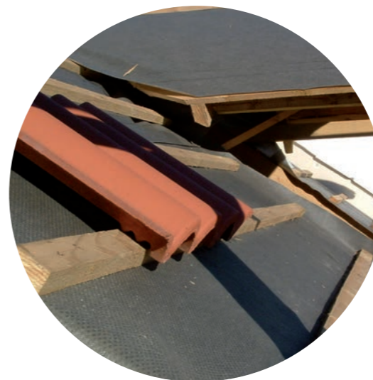
Az átszellőztetett fedési légrés hiánya
