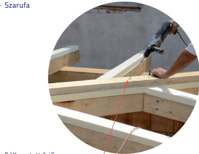
Süllyesztett fejű szerkezetépítő csavar
